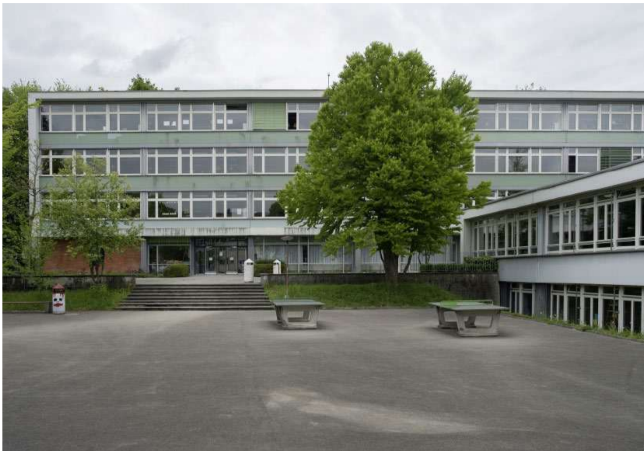
Der Heimatschutz will den Schutz für die Schule Hochfeld erhöhen - die Stadt lehnt dies ab. Fotos: Franziska Rothenbühler
