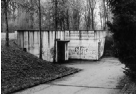
Reservoir Gurten der Berner Wasserversorgung – weitgehend in Hang gebaut
