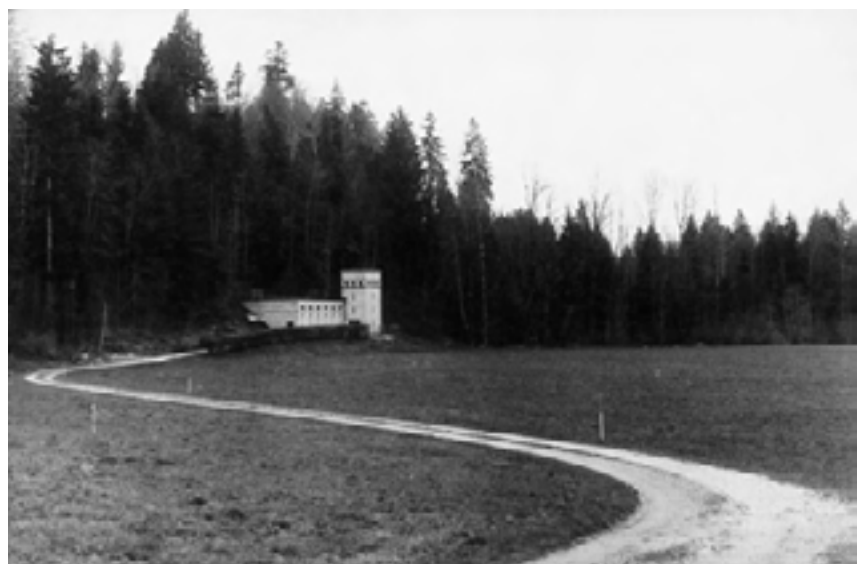
«Wasserschloss» der Berner Grundwasserfassung im Emmental bei Aeschau
