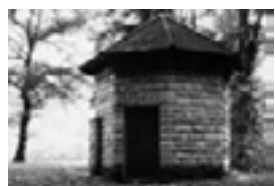
Brunnengebäude der Berner Grundwasserfassung im Aaretal bei Kiesen
