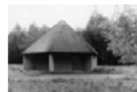
Brunnenstube in der Belpau
