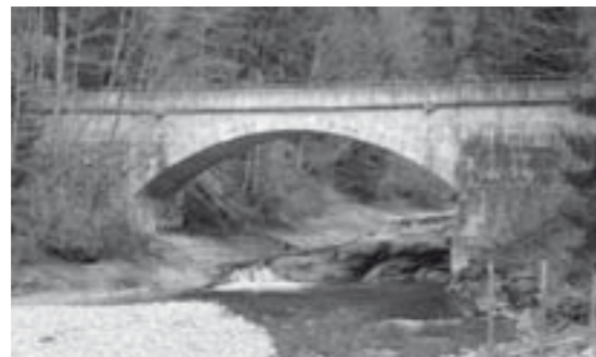
Schwarzenburg, Alte Schwarzwasserbrücke von 1831/32. Das Bauwerk ist Teil einer historisch bedeutenden Wegstrecke. Eine umfassende Restaurierung rettete die vom Wasser stark in Mitleidenschaft genommene Steinbogenkonstruktion. (Foto: Peter Bannwart)
