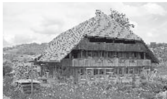
Worb, Richigen, Bachstrasse. Das rund dreihundertjährige Bauernhaus beherbergt heute eine grosszügige Wohnung im Minergie-Standard. Die ehemalige Rauchküche ist wieder über zwei Stockwerke offen und bildet wie früher das Zentrum der Wohnung. (Foto: Verena Gerber-Menz)
