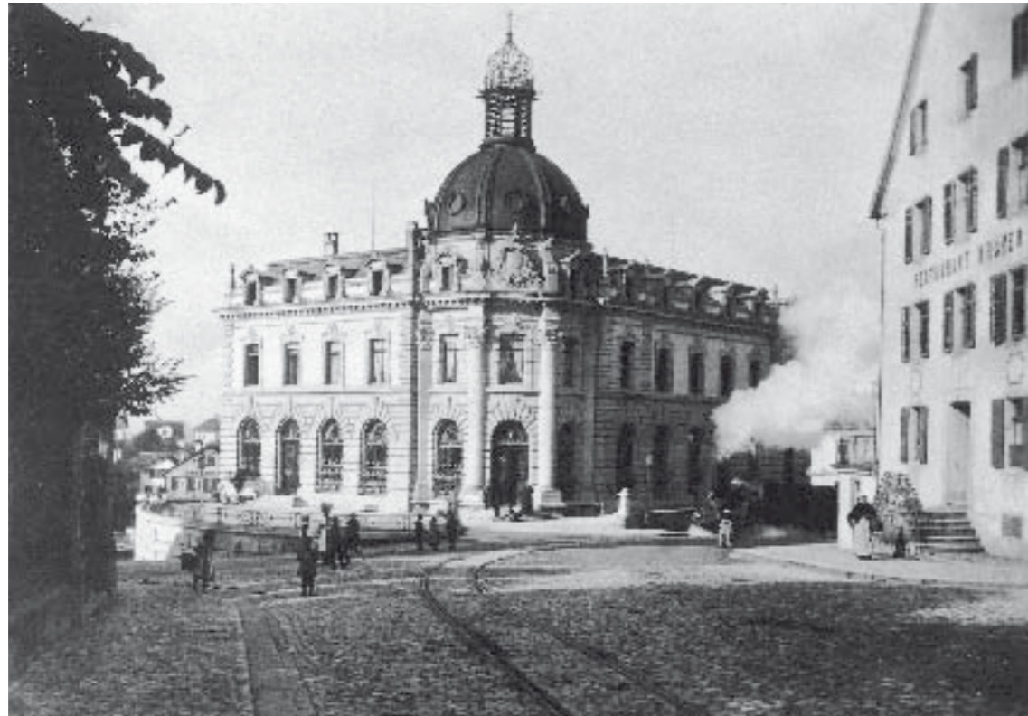
Frauenfeld, Postgebäude (1897–1899) von Theodor Gohl (Bundesamt für Bauten und Logistik)
