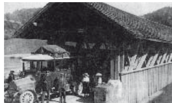
Der Seftausteg neben dem Felsenau-Kraftwerk, erbaut 1921
