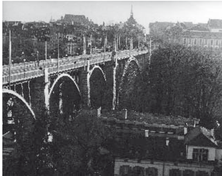
Die Kornhausbrücke mit markantem Hauptbogen und mehreren, zwischen Jurakalkpfeilern eingespannten Nebenbogen, 1896-98 unter Leitung des Berner Ingenieurs Simons von der Krienser Firma Bell konstruiert
