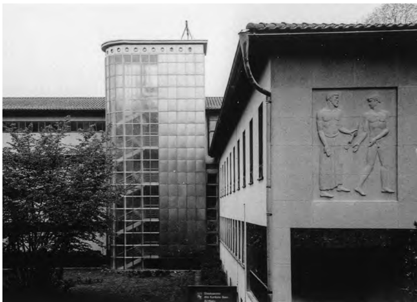
▲ 9 Die Berner Architektin Magdalena Rausser (*1940) erweiterte 1984-1985 Walter von Guntens (1891-1972) Staatsarchiv des Kantons Bern (erbaut 1939-1940) am Falkenplatz 4 um einen filigranen Treppenhausturm aus Stahl und Glas. Mai 1999.
