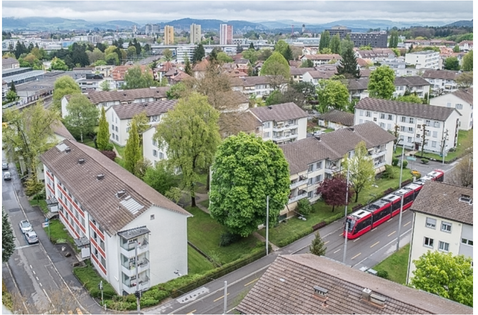
Die ab 1949 errichtete Siedlung Meienegg in Bern
