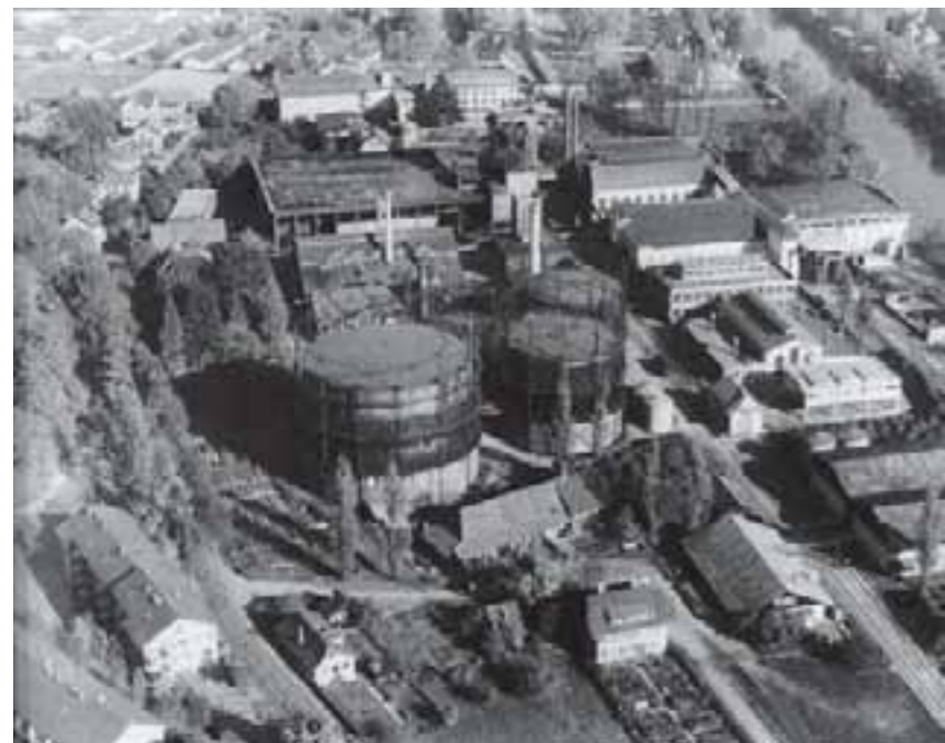
Die imposanten Anlagen des einstigen Berner Kohle-gaswerks in der Lindenau. In der Bildmitte rechts ist zwischen Reinigeranlage und Kohlemagazin die erhalten gebliebene Werkstatt zu erkennen. Aufnahme vor dem Bau der Monbijoubrücke am Nordrand des Areals. (Ballonaufnahme: Stadtarchiv Bern)
