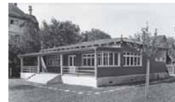
Der Länggasskindergarten von Westen nach seiner Wiederaufstellung
