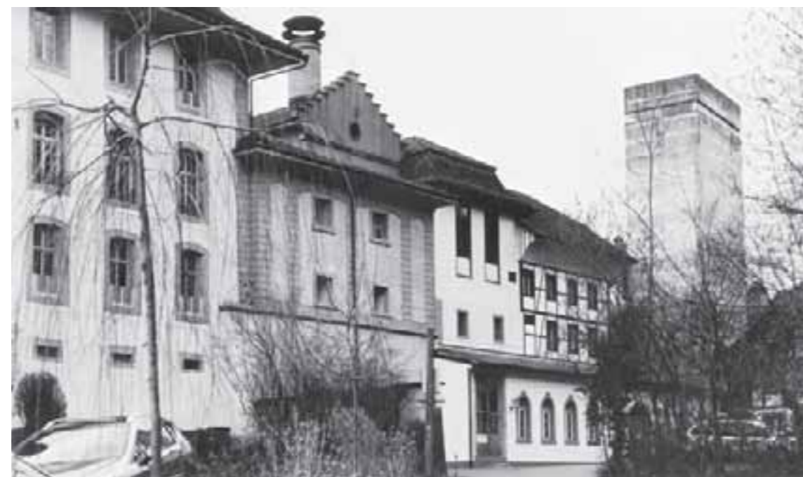
Schloss Reichenbach bei Zollikofen (links) mit anschliessenden ehemaligen Brauereibauten samt Malzsilo
