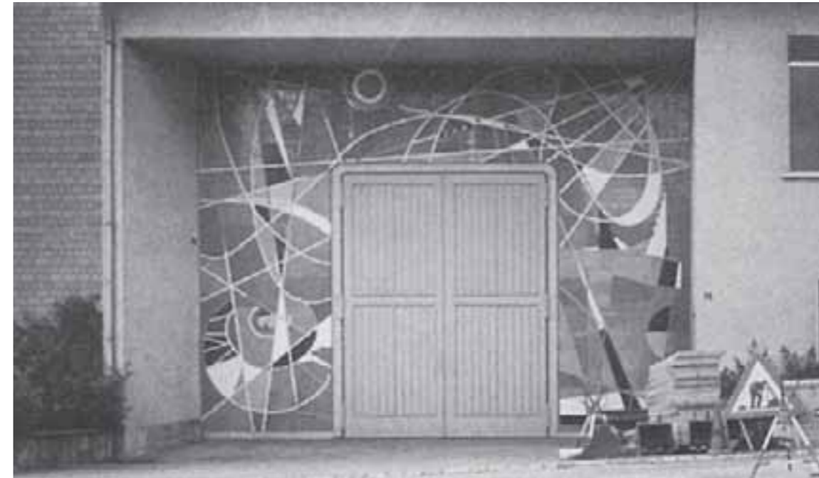
Albert Neuenschwander, Die elementaren Faktoren der Elektrizität, 1952, Unterwerk Schosshalde des Elektrizitätswerkes Bern
