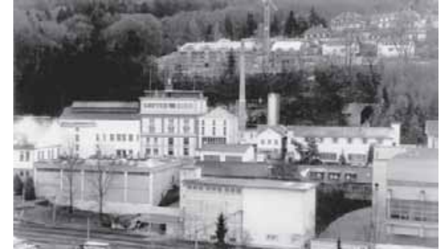
Bauten der Gurten-Brauerei samt Hochkamin mit Initialen J.J. des Firmengründers am Nordhang des Berner Hausbergs in Wabern
